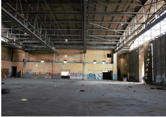
Ansicht Nordseite innen
