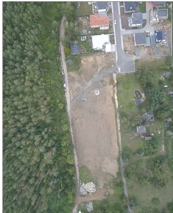
Abbildung 2: Planfläche nach Beräumung und Entsiegelung, Luftbild (Quelle: C. Funke; Datum der Aufnahme: 24.08.2021)
