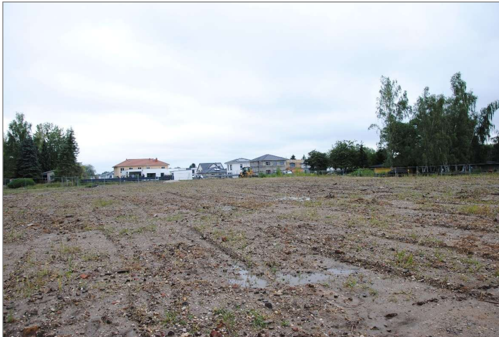
Abbildung 1: Planfläche nach den durchgeführten Entsiegelungsmaßnahmen und Beräumung, Blick nach Norden (Quelle: gIR, Datum der Aufnahme: 24.08.2021)
