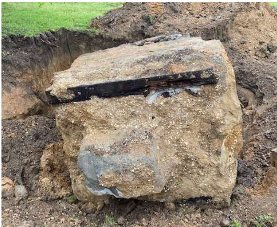
Abbildung 6: Entnommenes Betonfundament (Quelle: C. Böhler, Datum der Aufnahme: 04.05.2021)
