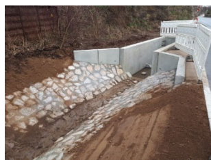
Einlaufbereich Bornshainer Bach
