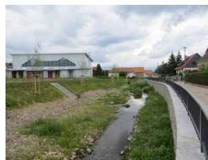
Gewässeraufweitung nach Fertigstellung
