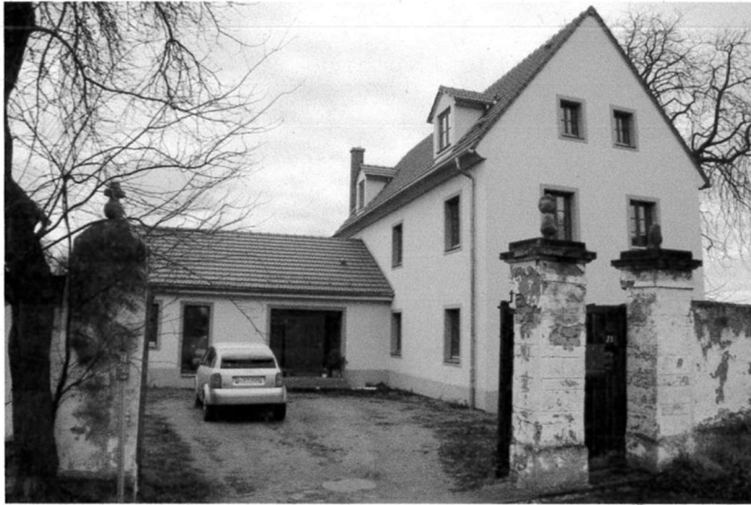
An der Kirche 23, Dreiskau-Muckern (Haupthaus; ohne Anbau)
