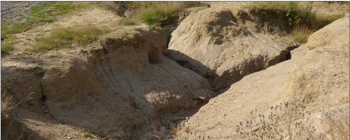
Abb. 15: ausgewaschene Sandfläche im Bereich des Zuweges zum Strand
